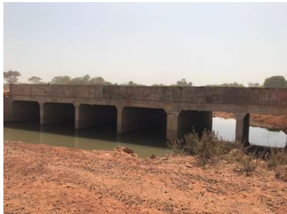
Pont à 6 passes au PK12 (entre Katélé et Kadiolo)
