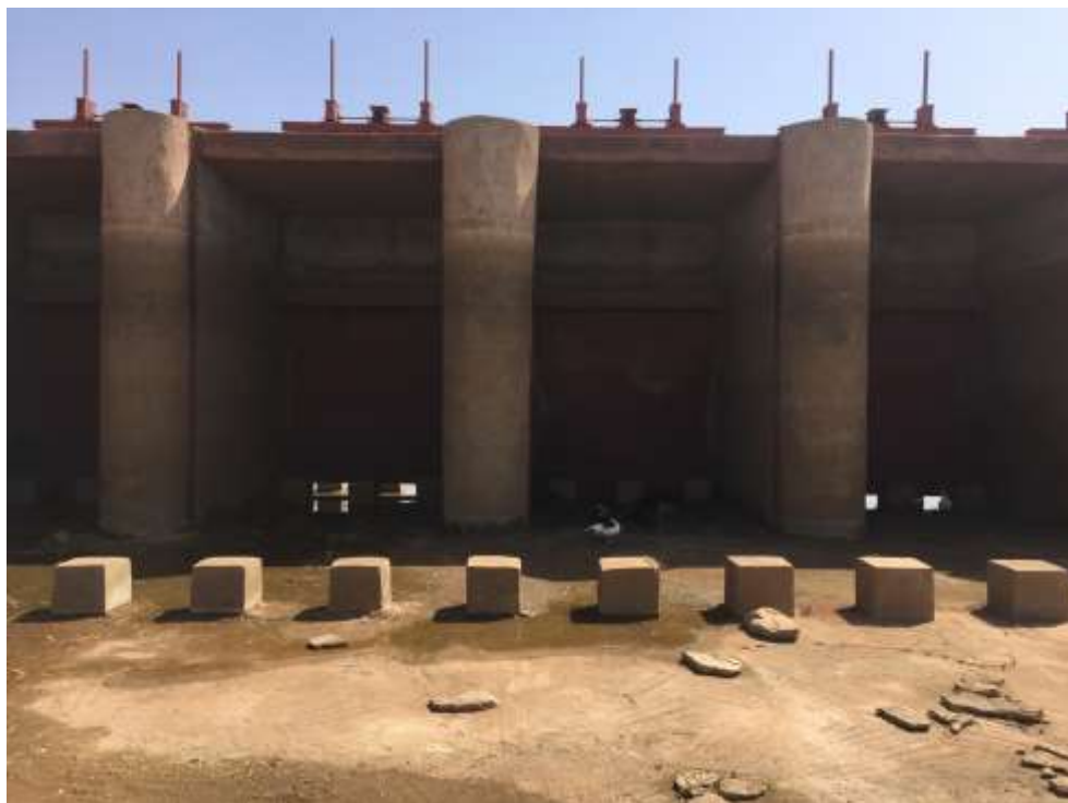
Ouvrage de prise de Togorogo
