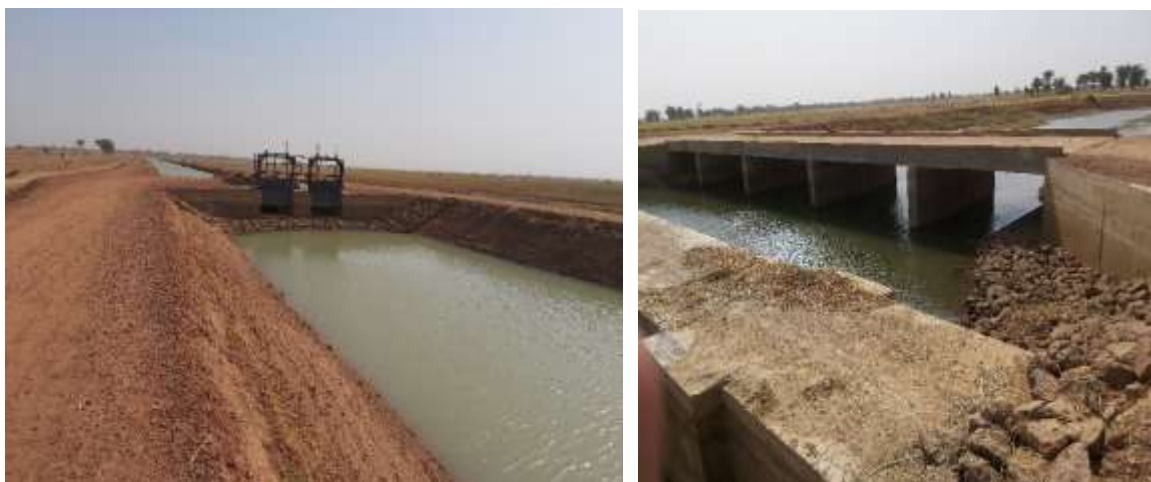
Une vue des travaux réalisés
