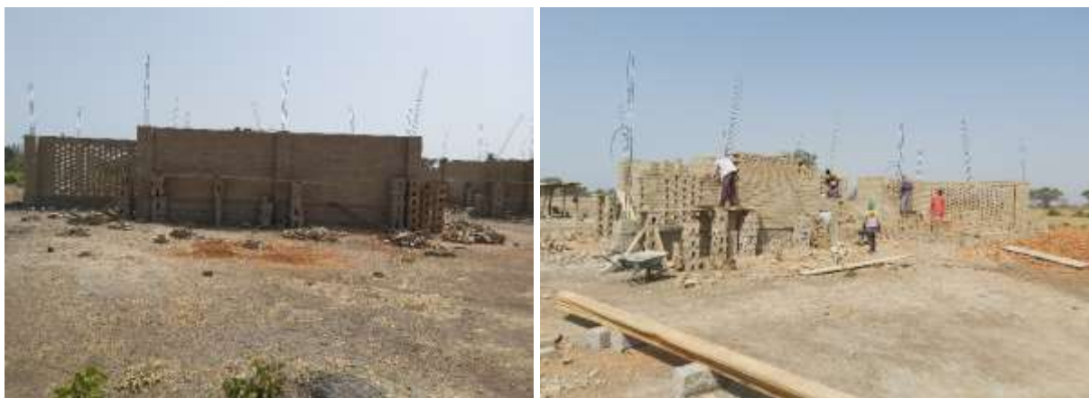
Vues des travaux en cours du ZAE
