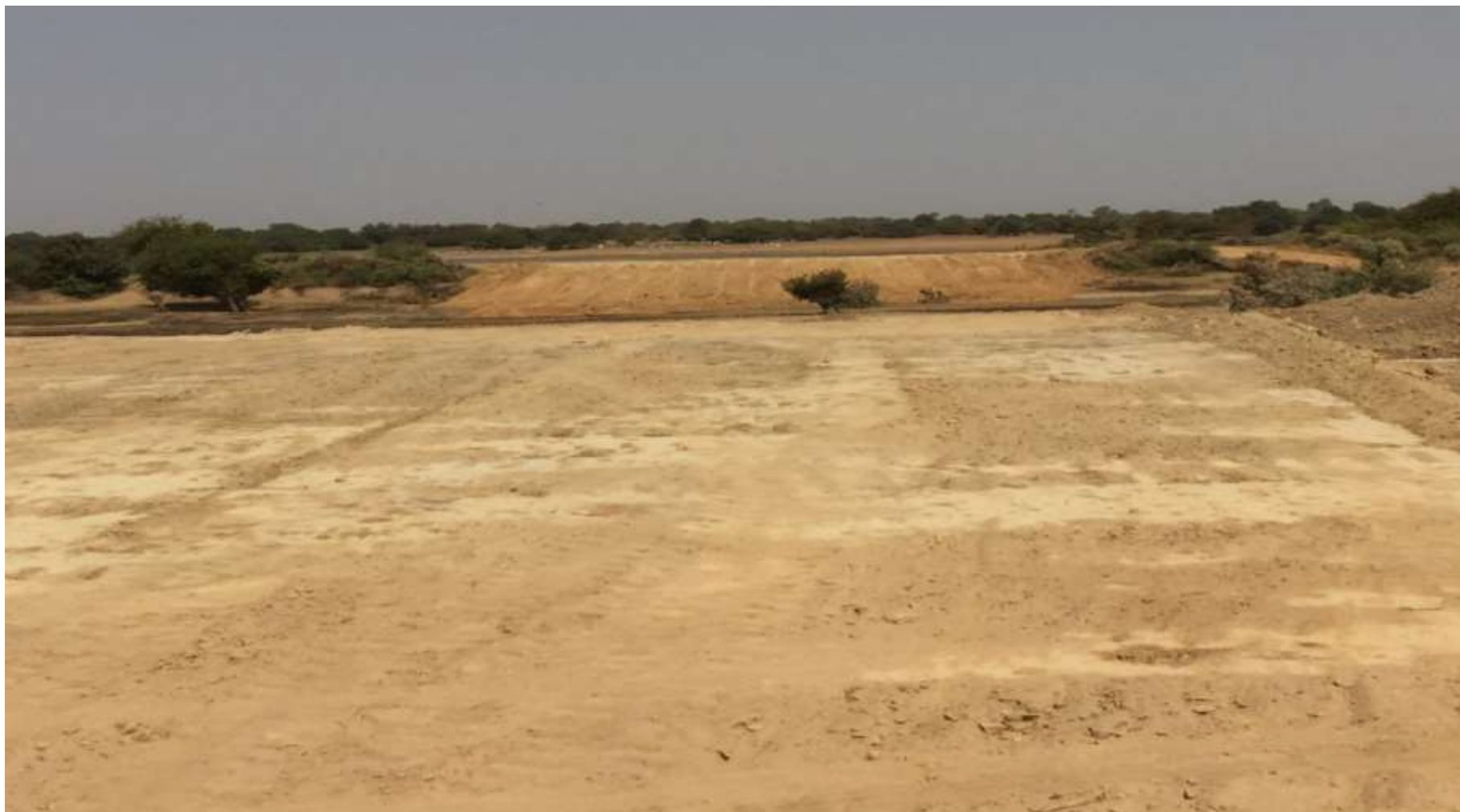
Le canal adducteur de 3,4 km
