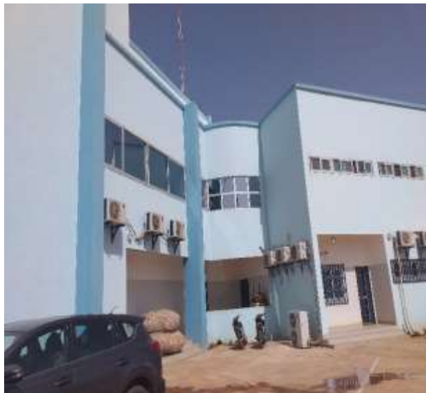
Aperçu de la construction de la Direction Général du LNE
