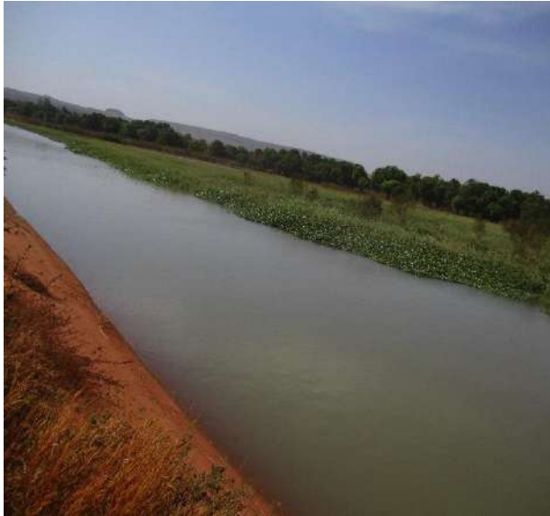
Lot 1 ; Revêtement de la tête morte PK 0 à PK 1,85
