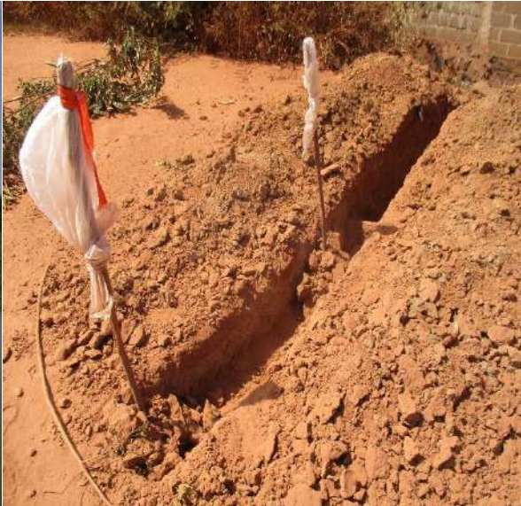
Travaux de branchement illicite d'un particulier
