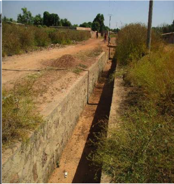
Aménagement de voirie urbaine
