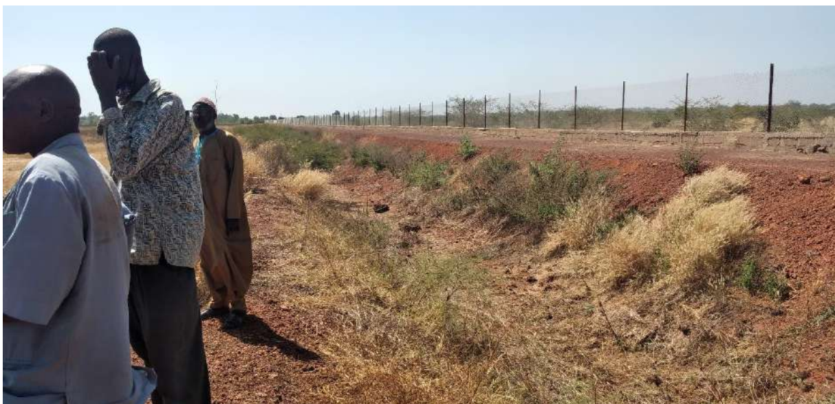
Aperçu de la digue de protection
