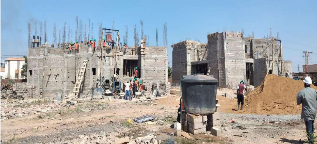
Aperçu Sud-Ouest du Bâtiment
