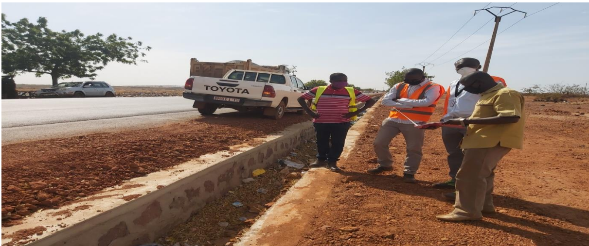
Caniveaux réalisés à Kati-ville
