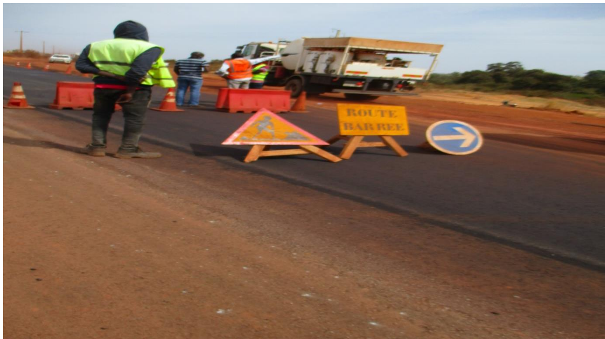
L'entreprise en activité sur le terrain
