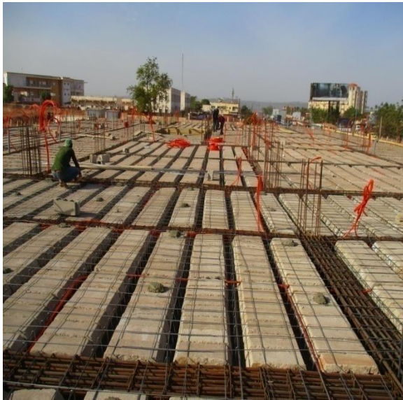
Toiture en préparation R+1
