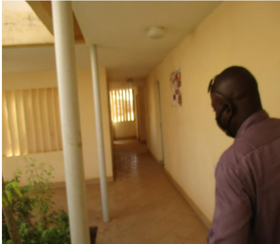
Couloir des locaux UAPIA de Kayes
