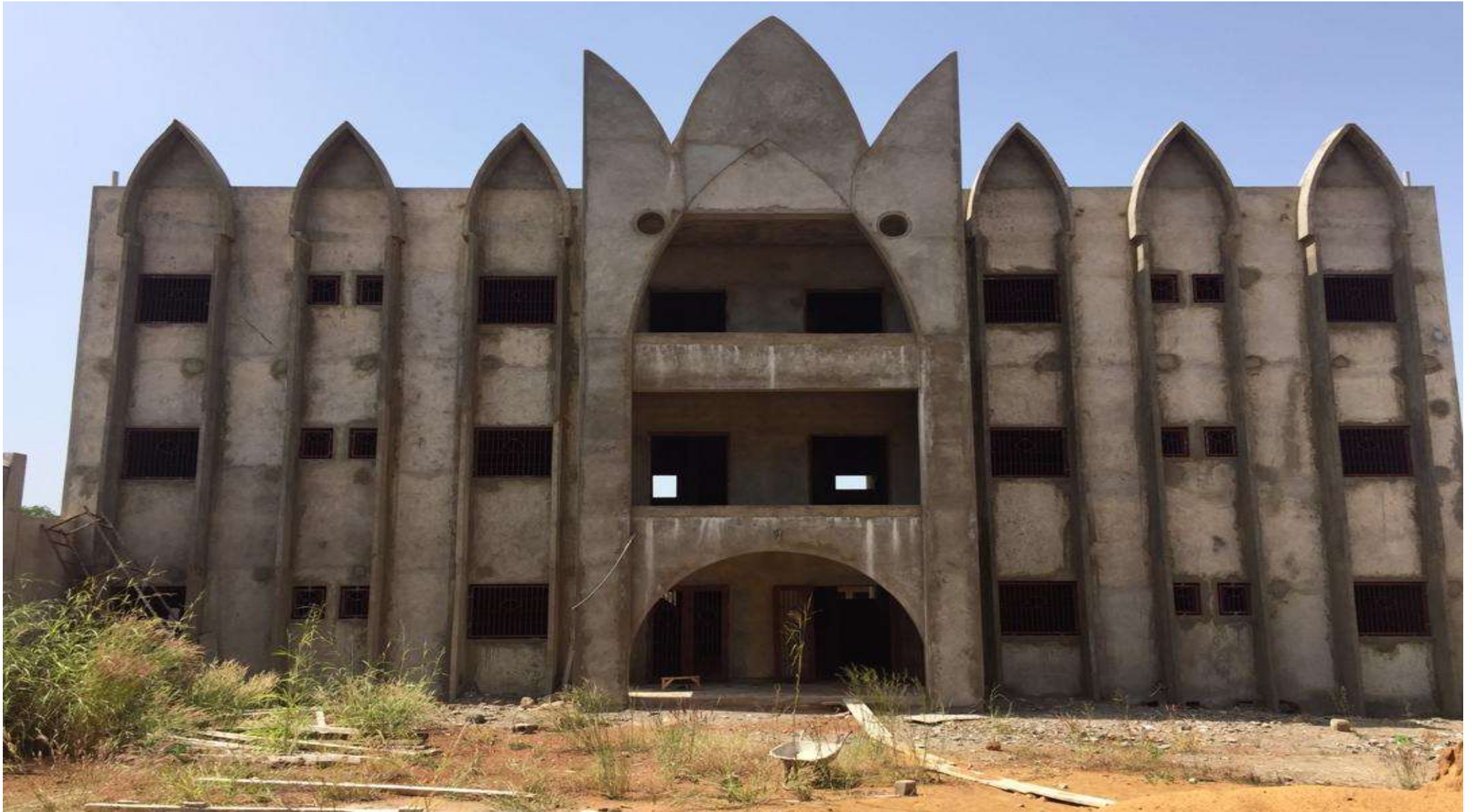
Maison Centrale d'Arrêt de Bamako à Kénioroba (bloc VIP)
