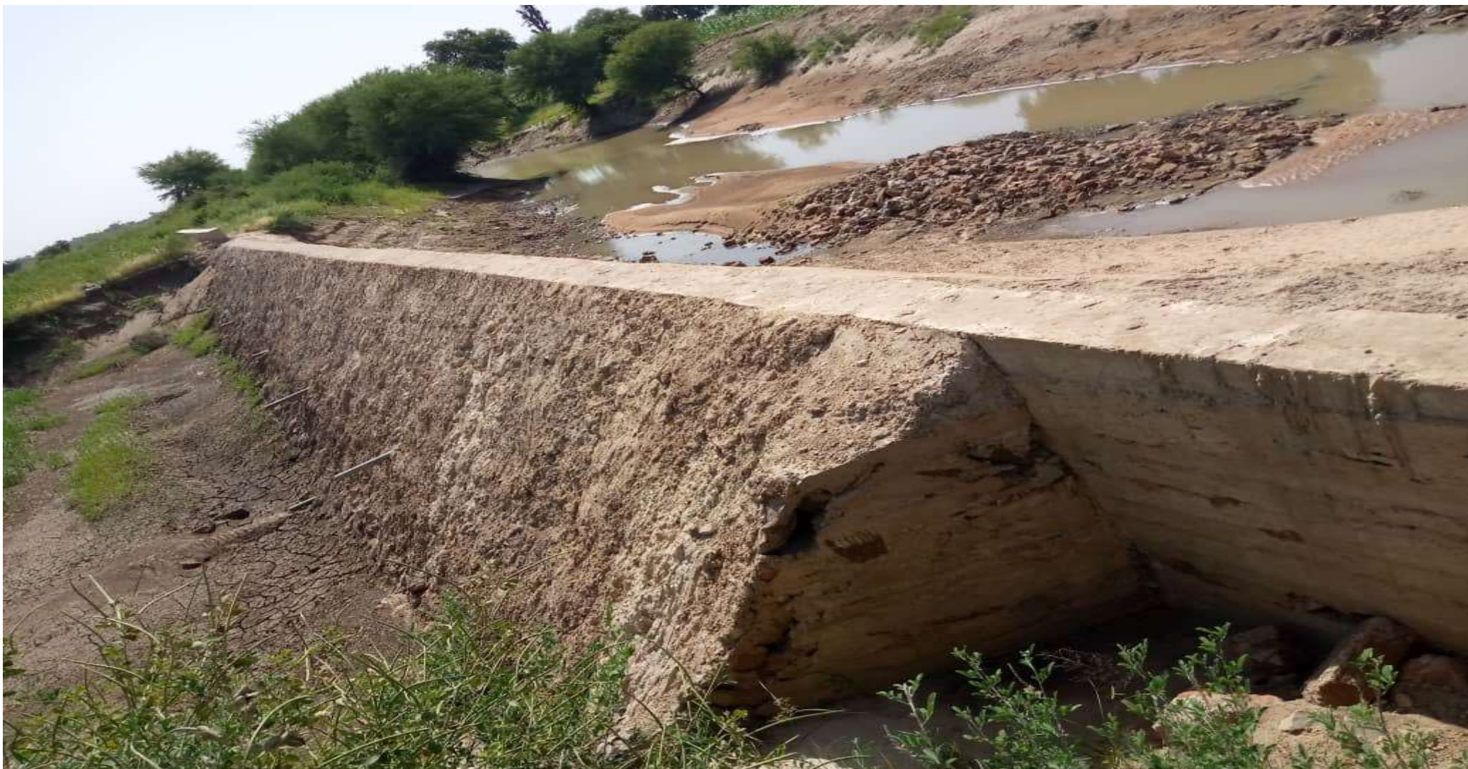
Digue de koméoulou
